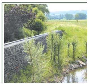
Der Platz zwischen Straßendurchlass und Wohnbebauung erlaubt nur eine Stahlspundung mit Drahtschotterwand als Objektschutz, erst an deren oberem Ende ist ein Deich als Hochwasserschutz möglich. (Foto: Diehl)
