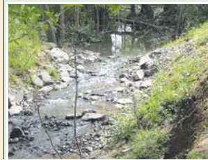
Die Steinschüttung bildet eine Schwelle, hinter der Fein- und Grobsubstrat sedimentieren kann. So hebt sich nach und nach die Gewässersohle an. (Foto: Diehl)
