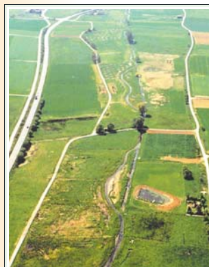
Erster Bauabschnitt zwischen Hachborn und Ebsdorf nach Fertigstellung der Baumaßnahme im Frühjahr 1989; oberer Bildrand: Gemarkung Hachborn. (Foto: Badouin)
