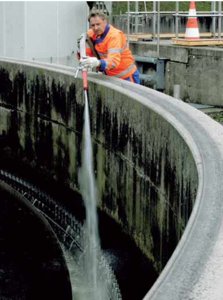
✓ Auch die Kläranlage muss "in Schuss" gehalten werden. Bernhard Kitt reinigt die Ablaufrinne des Nachklärbeckens.
